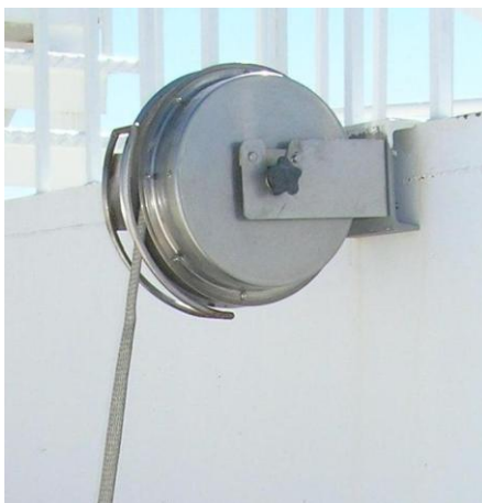
Figura 9: La Asamblea Retractable Puesta a Tierra (RGA) en un Tanque con Techo Flotante
