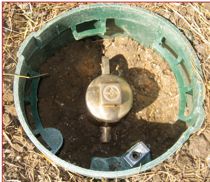
Electrodo para tierra Chem-Rod correctamente instalado
