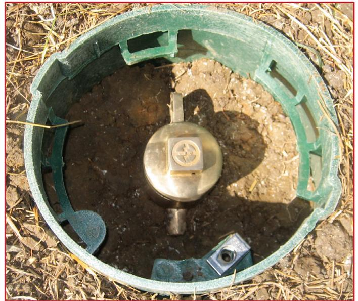
**Électrode de terre Chem-Rod posée dans un puits de service.**
